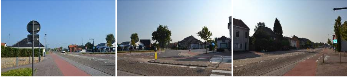
Zicht op kruising van de Lommelsebaan (resp .foto links en foto rechts) en de Ekselsebaan (foto midden) vanuit de Twaalf Septemberstraat;
