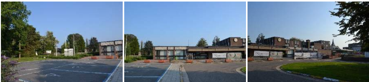
Zicht op het ontmoetingscentrum 'De Schans' met links de toegang tot de gemeentelijke speeltuin De Schans;
