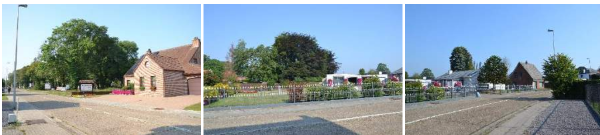
Zicht op de bebouwing langs de Don Boscostraat, aansluitend aan de Byvoetstraat;
