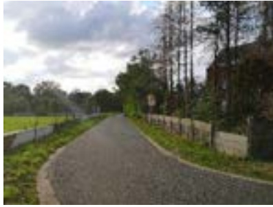
5. Zicht op de hoefstraat, vanuit de aansluiting met de Hasseltsebaan;
